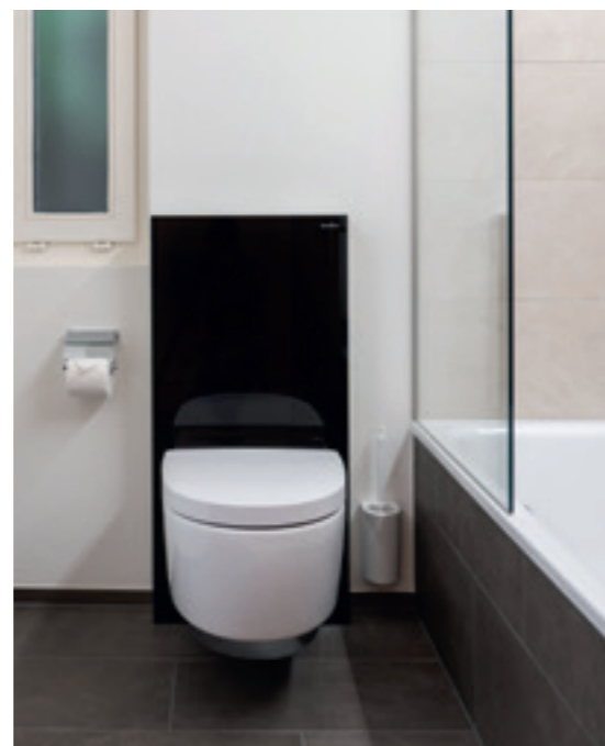
APRÈS Installation avec Geberit Monolith
