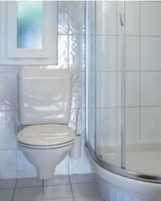
AVANT Installation avec réservoir apparent
